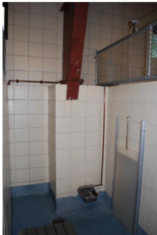
主體完工後裝設給水系統
