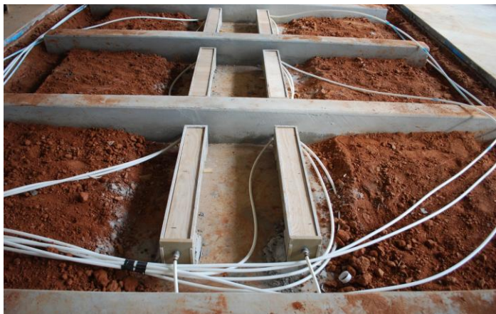
正確安裝噴嘴以利沖刷水溝
