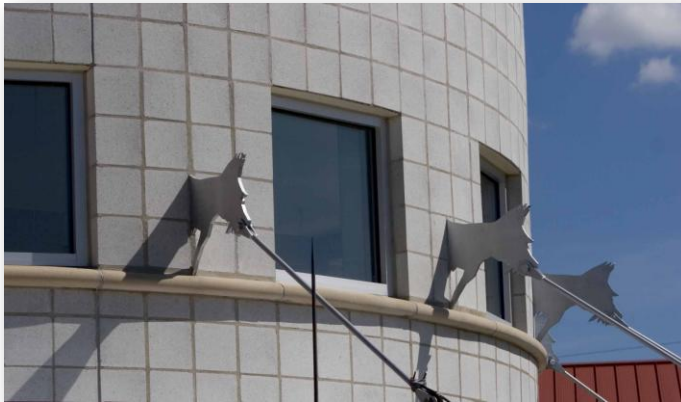
狗頭形狀的托架支撐著入口處的天蓬 (蒙哥馬利動物資源中心)
